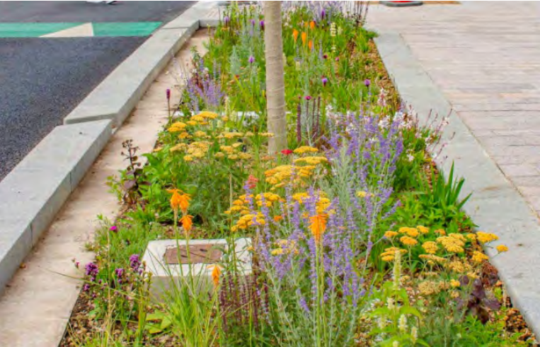
VEREDÓN SUSTENTABLE / RECOLECCIÓN DE AGUAS LLUVIAS
